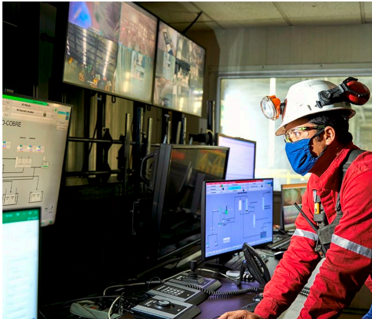
Cuarto de control, planta Tizapa
