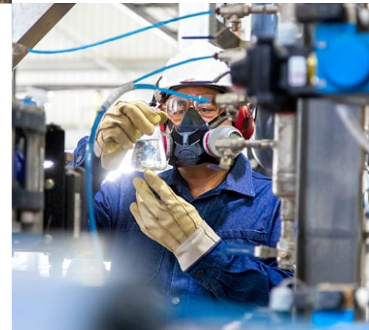
Filtración final planta de tratamiento de aguas residuales, Met-Mex
