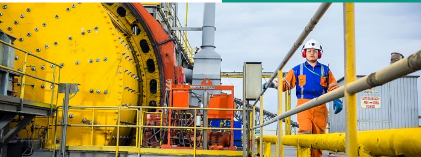
Planta de molienda, unidad Madero
